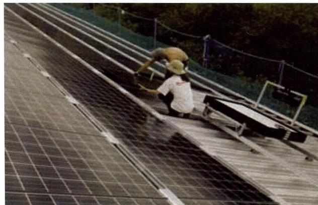
2 Die Montage von Kollektoren darf nur mit Kollektivschutz ausgeführt werden (Dachfangwand, Gerüst mit Spenglergang usw.).
